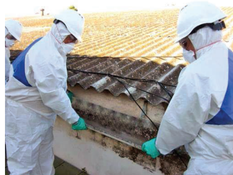
RETIRO DE ASBESTO
