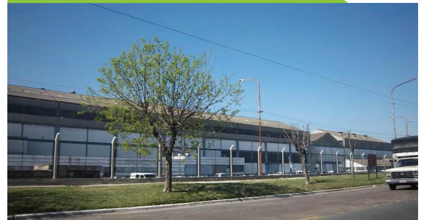
TECHOS DE CHAPA DE FIBROCEMENTO / Universidad de La Matanza
