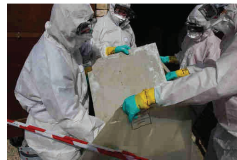
RETIRO DE ASBESTO
